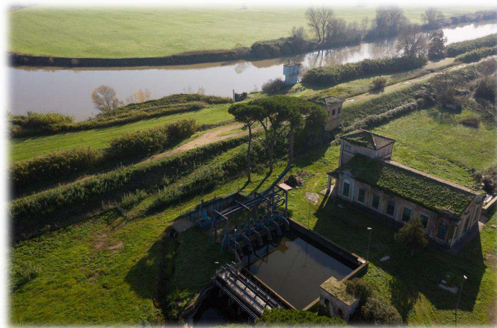
Foto dell'impianto irriguo di Ponte Galeria
